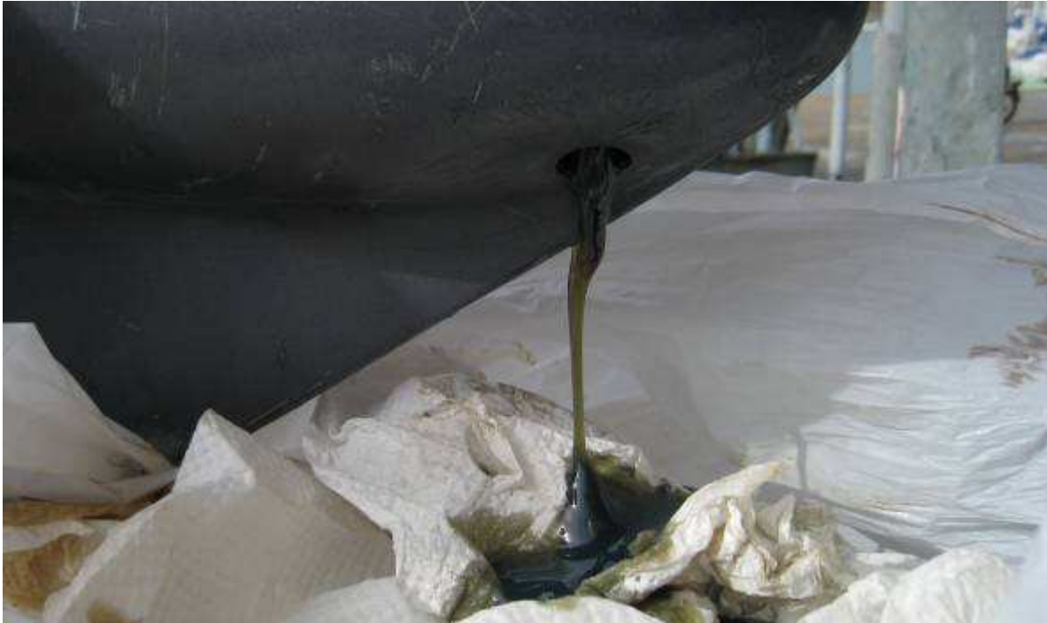
写真 11 ギヤオイルの排出
